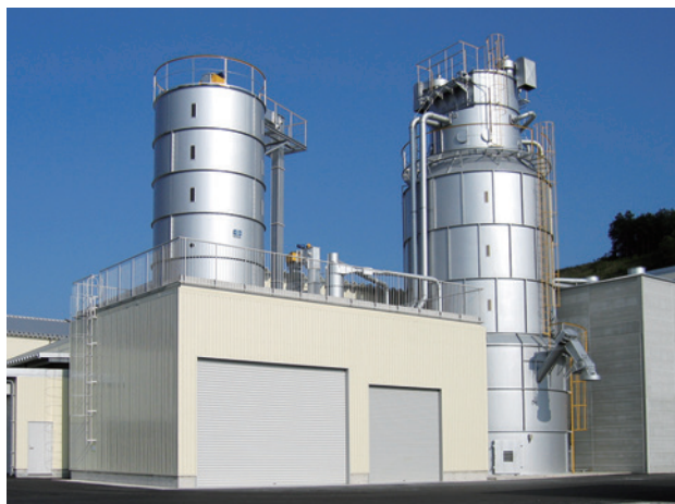
生産能力：1,000kg/h ペレットサ－：SPM500(55kw×2)
