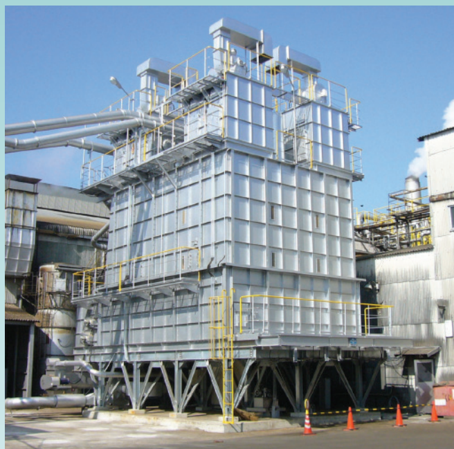
SRR6W3 : 350m³ バグフィルター集塵機付
